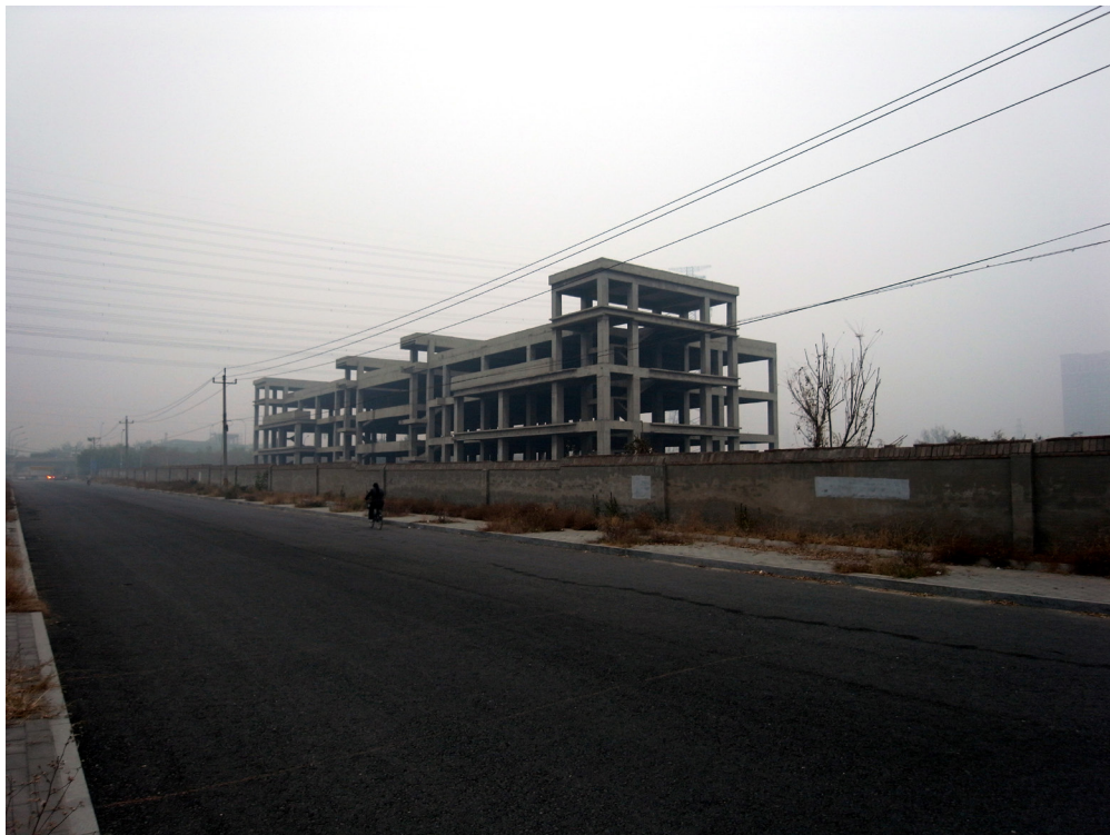
Carcasse de bâtiment abandonné à Gaobeidian, Pékin. Jérémie Descamps, 2011
