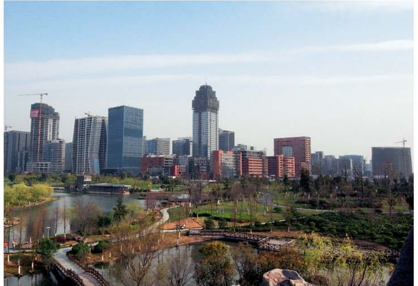
宁波中央商务区 Ningbo CBD
