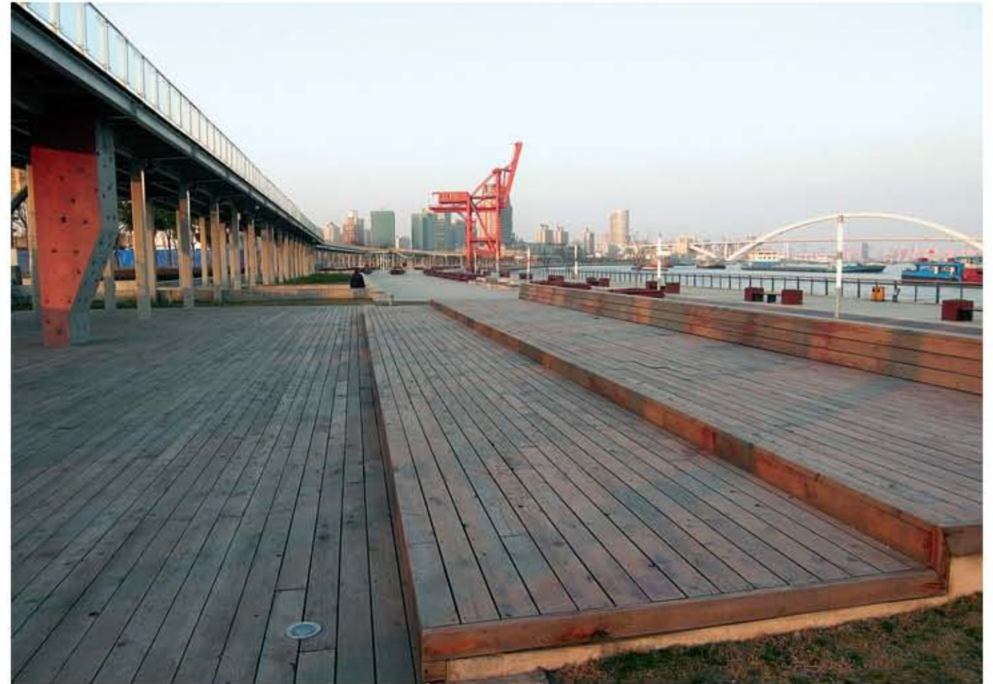
上海徐汇滨江公园 General view on the Corniche, Shanghai
